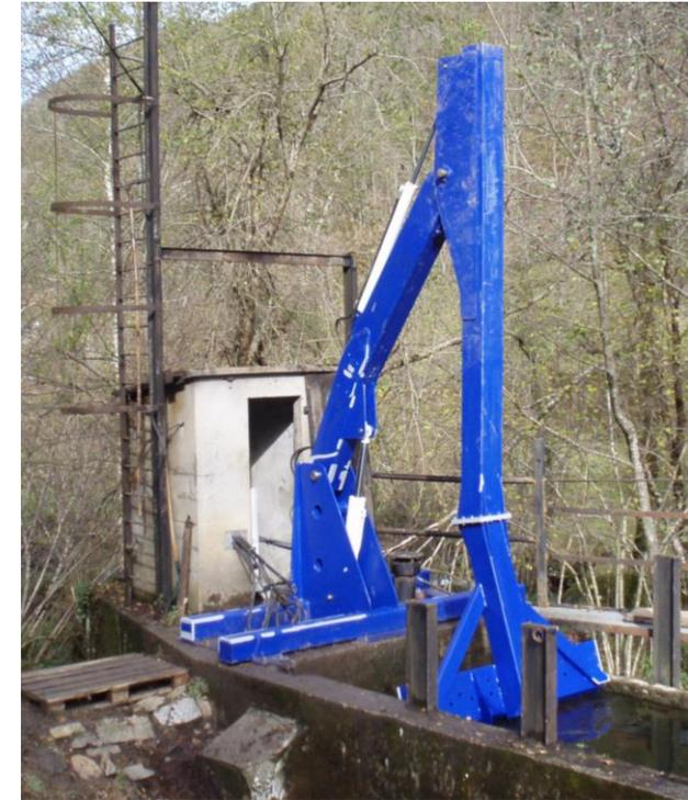
Dégrilleur hydraulique type Pelle
